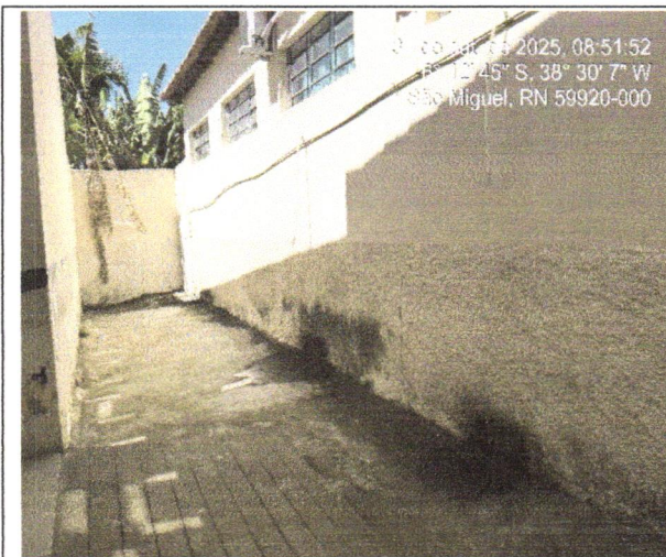
Acesso – Bloco B
